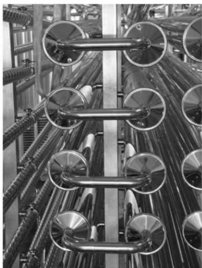
Lo scambiatore di calore tubolare ViscoLine collegato in serie con isolamento.
